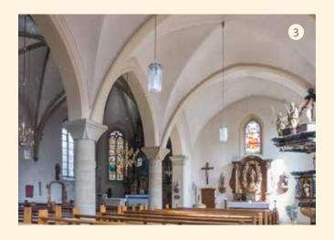
Südwand, die für den Anbau aufgebrochen und auf Säulen gesetzt wurde.
